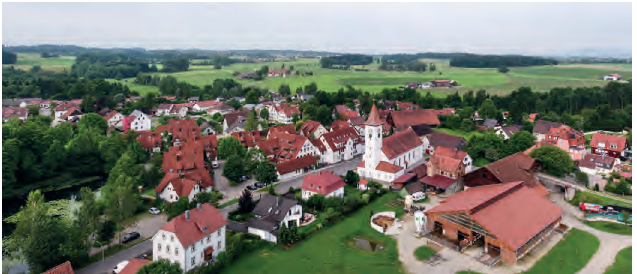
▲ Die Gemeinde Schlier in Baden-Württemberg zeigt in der Praxis, wie ein neues Wohnbaugebiet möglichst klimaneutral und zugleich kostengünstig mit Strom, Wärme und Mobilität versorgt werden kann.
