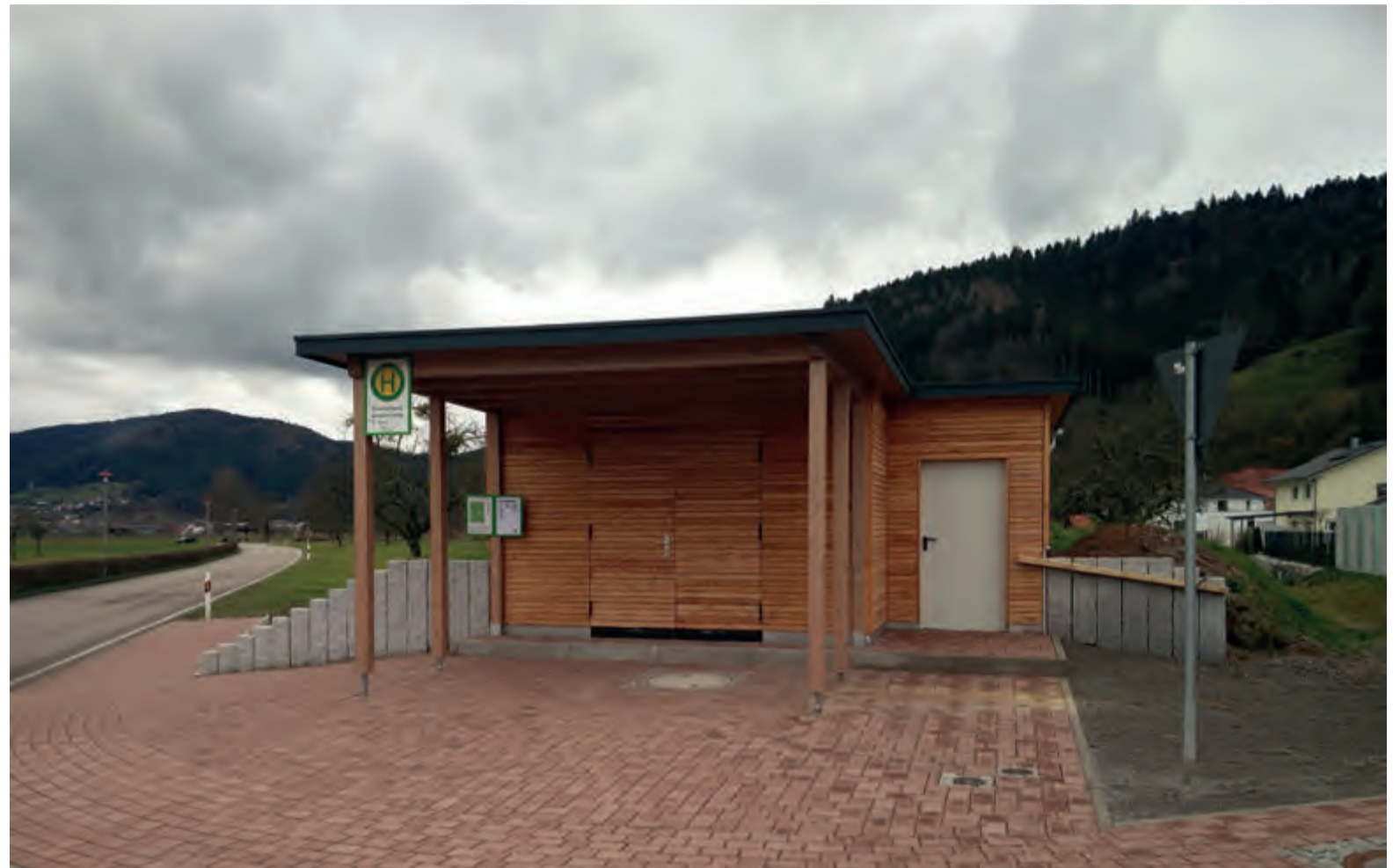
▲ Die Technikzentrale als Bushaltestelle in Fischerbach
